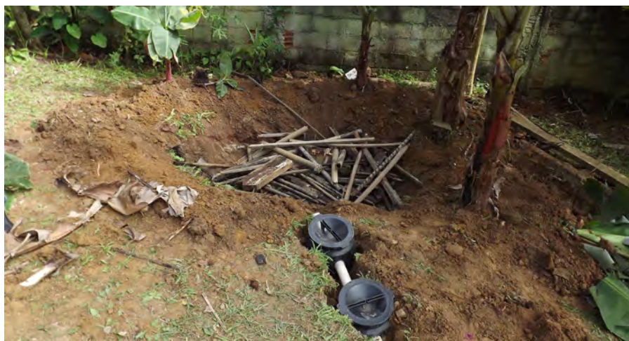
Foto 10 – Cobertura do buraco com troncos largos no fundo e galhos em cima.
