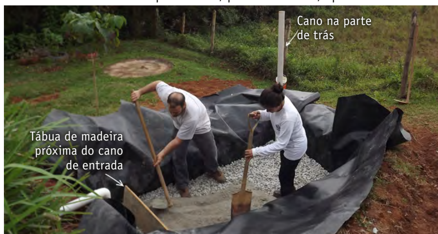
Foto 15 – Preenchimento da vala com brita e areia.
