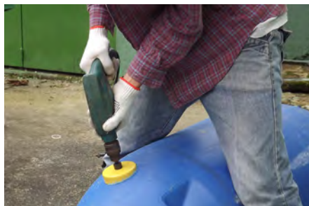
Foto 32 – Furos de 100mm para o encaixe dos canos.
