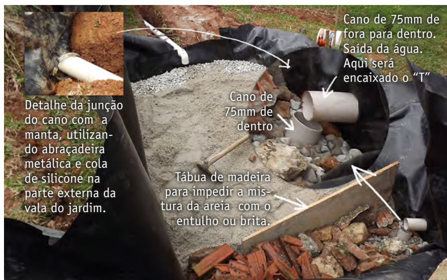
Foto 16 – Preenchimento da vala com brita e areia.
