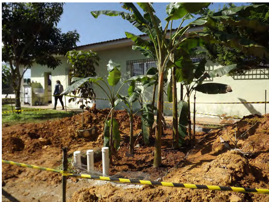
Foto 25A – BET – Bacia de Evapotranspiração na UBS Jardim Embura
