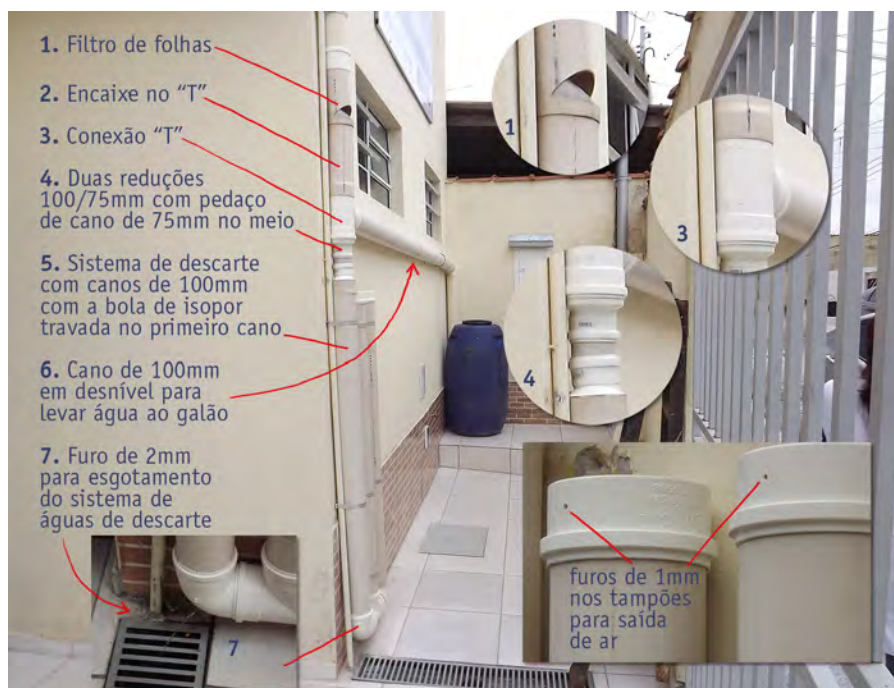
Foto 31 – Detalhamento da cisterna.
