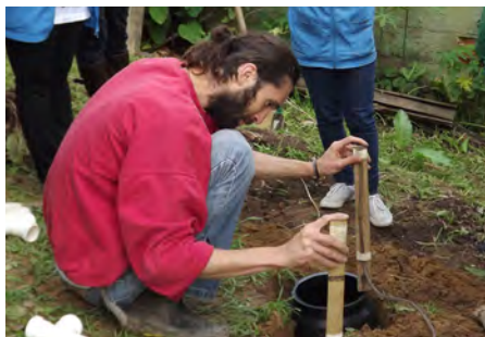
Foto 8 – Verificação do desnível entre os galões com a mangueira de nível.
