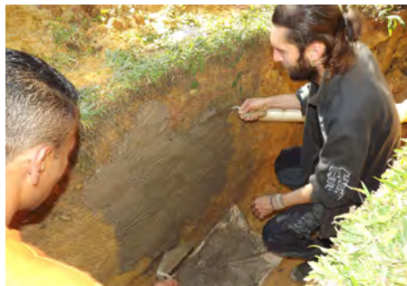
Foto 23 – Cobertura da tela com cimento.
