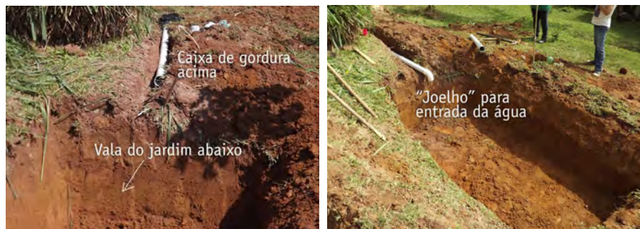
Foto 12 – Exemplo da vala do jardim filtrante. Foto 13 – Exemplo da vala do jardim filtrante.
