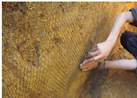
Foto 22 – Fixação da tela na parede.
